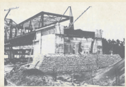
สะพานรถไฟพระราม ๖ ในระหว่างการก่อสร้าง
