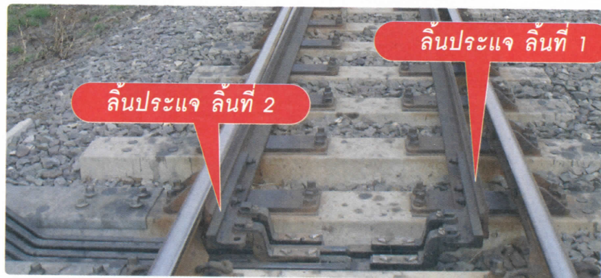
รูปแสดงลื่นประแจ ของประแจกลหมู่ชนิดทำงานด้วยไฟฟ้า
