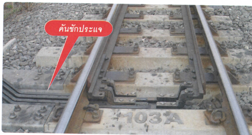
รูปแสดงคันทักประแจ ของประแจกลหมู่ชนิดทำงานด้วยไฟฟ้า
