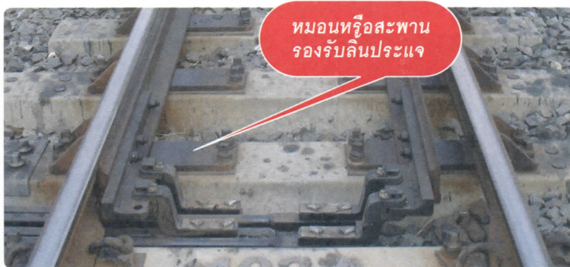
รูปแสดงหมอนหรือสะพานรองรับล้นประแจ ของประแจกลหมู่ชนิดทำงานด้วยไฟฟ้า
